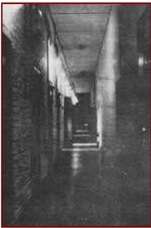
Couloir du Bloc 24
